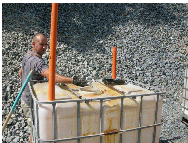
Raccordi in PVC 50 mm di carico e scarico del biofiltro
